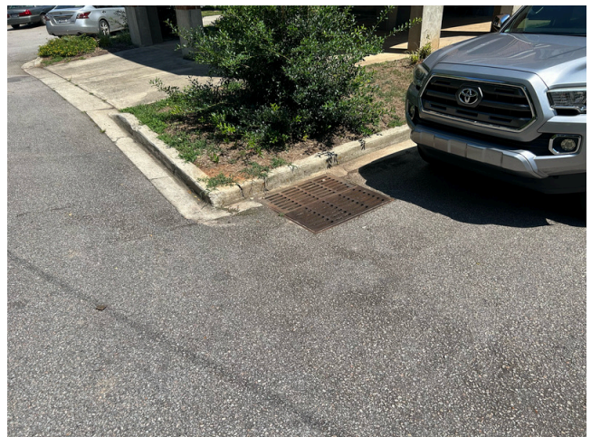
48. Site - storm drain
